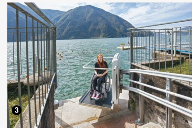
Area d'accesso al lago: l'installazione di un montascale sulla scala esistente permette di raccordare il livello del lido con il piano di accesso all'acqua. Un sollevatore idraulico consente la discesa in acqua.
