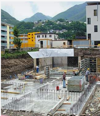
2007: il cantiere per la costruzione dello stabile di inclusione andicap ticino in Via Linoleum 7 a Giubiasco viene avviato.
