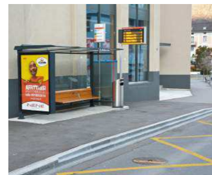
La fermata «test» in via Pellandini a Bellinzona.
