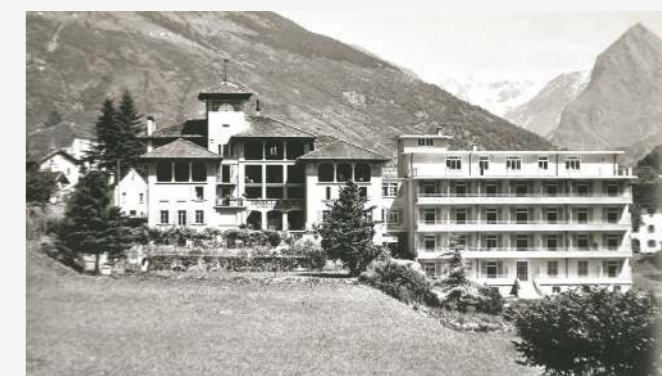
Il quarto ampliamento dell'Ospedale Bleniese (1936-1941)
